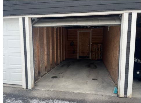
Garasjeplass og bod i felles rekke.
