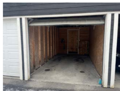
Garasjeplass og bod i felles rekke.
