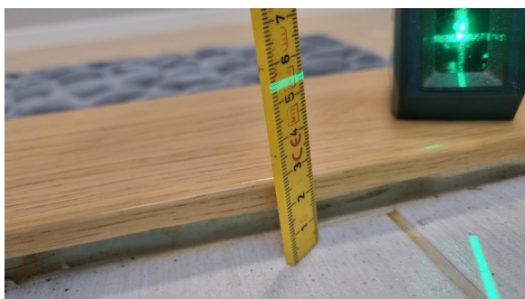
Kontroll av fall til sluk.
