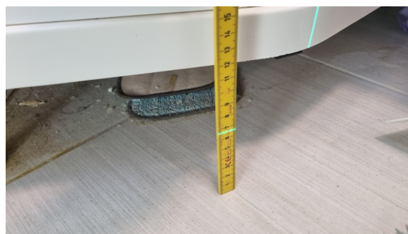
Gulvet har fall til sluk.
