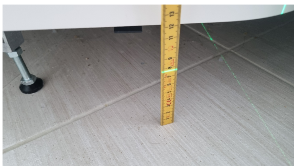
Gulvet har fall til sluk.
