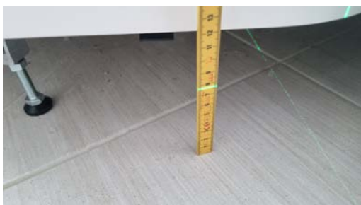
Gulvet har fall til sluk.
