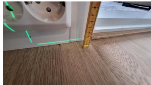
Kontroll av planavvik.
