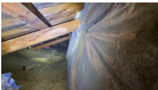
Det er dampsperre på kald side av knevegg
