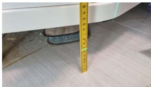
Gulvet har fall til sluk.
