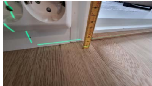
Kontroll av planavvik.
