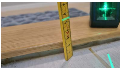
Kontroll av fall til sluk.
