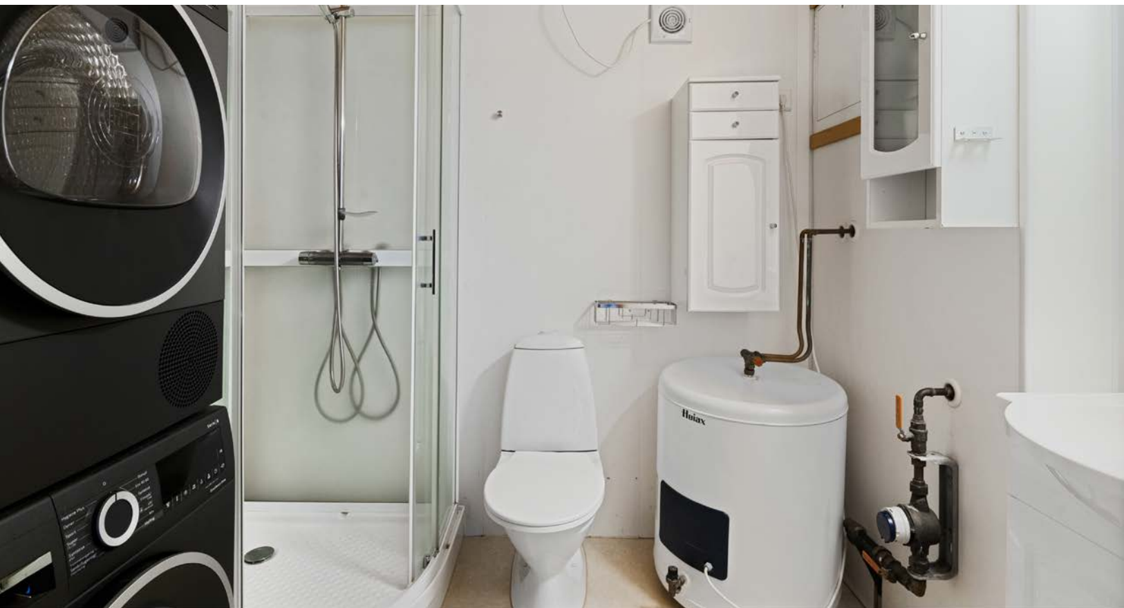
Bad og vaskerom i leiligheten. Et arealeffektivt rom med dusjkabinett, vask i servant, frittstående toalett og opplegg til vaskemaskin.
