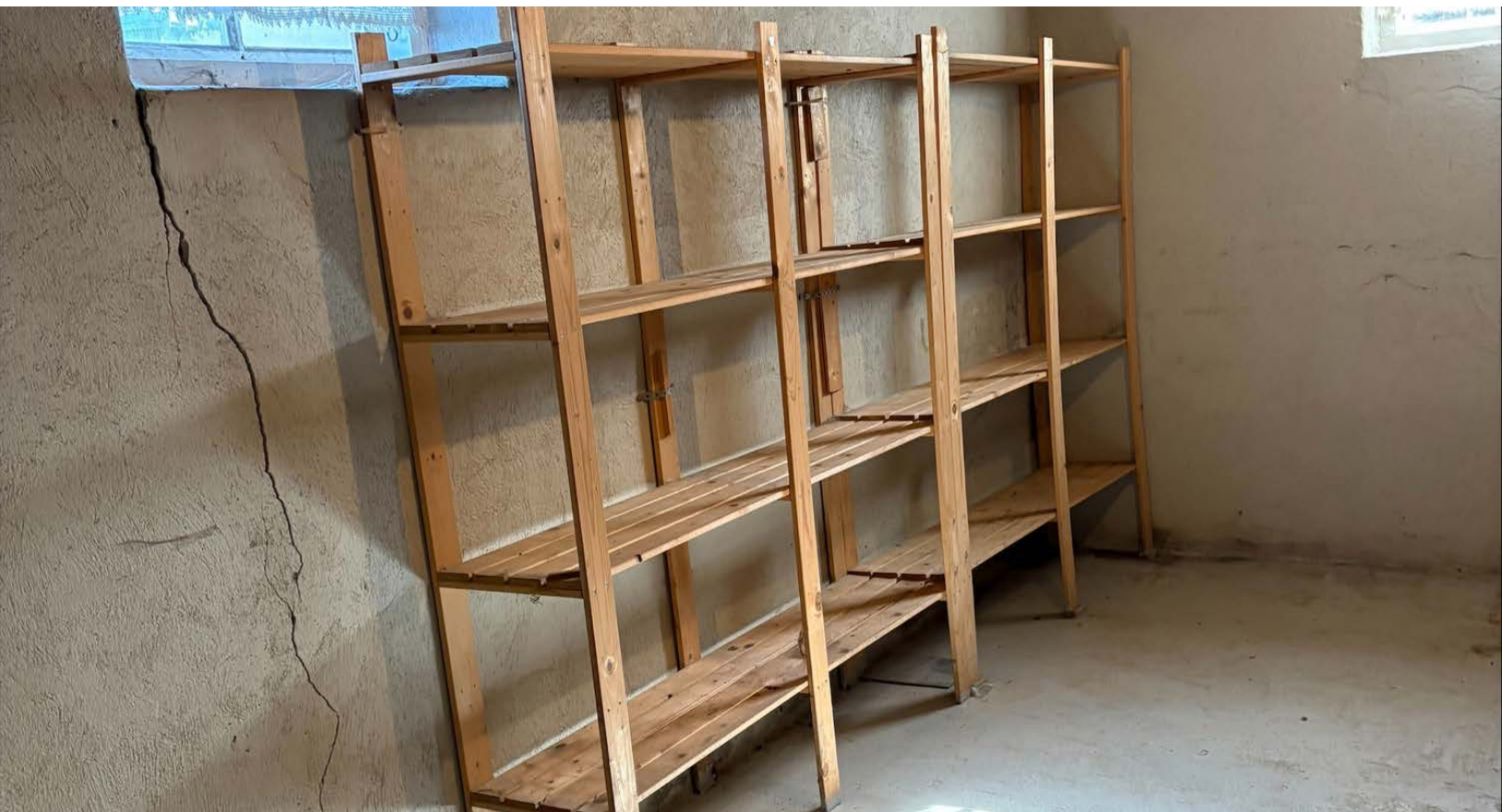
Bildet viser en av kjellerbodene.
