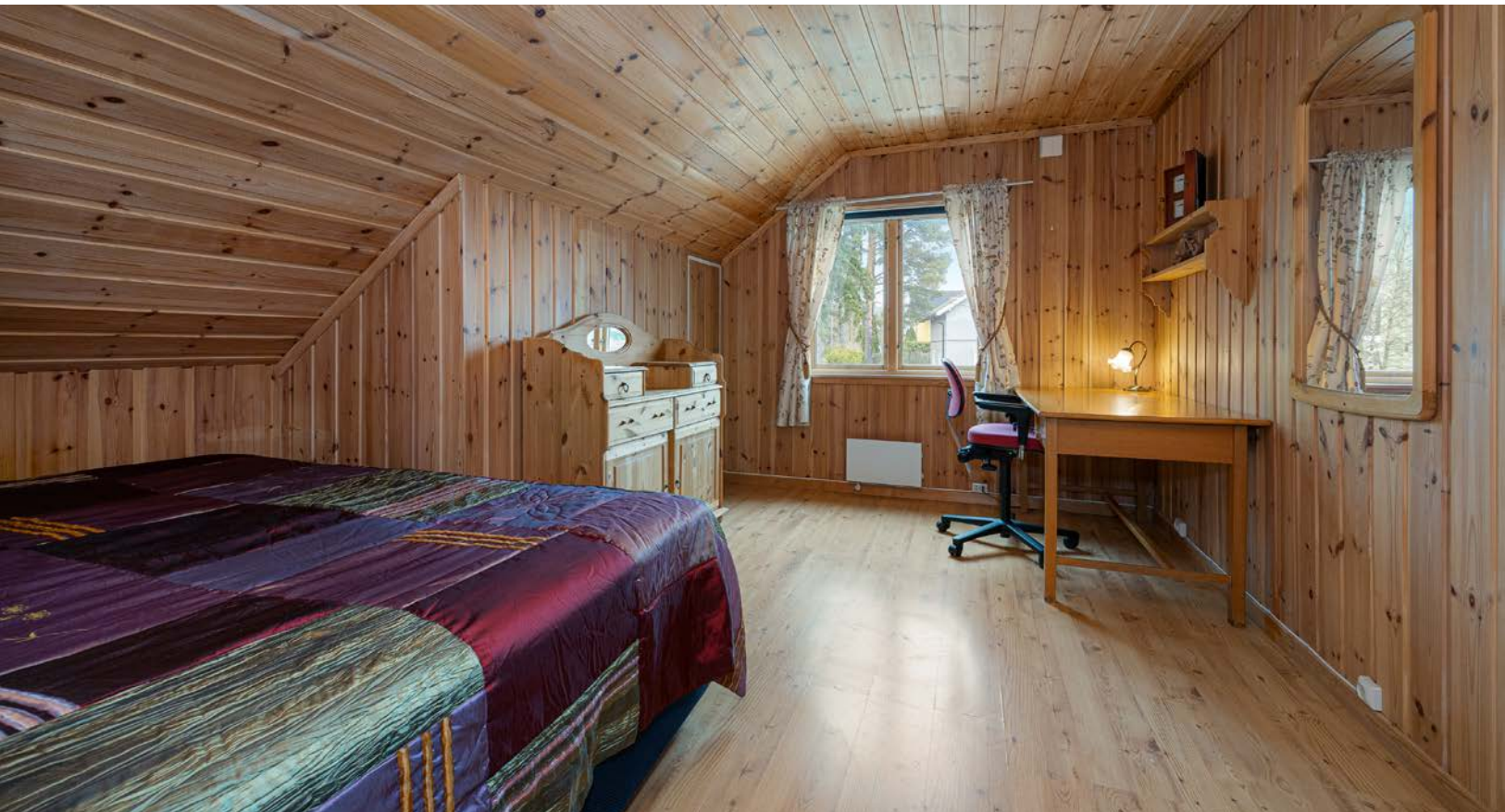
Begge soverommene har for liten dagslysflate i forhold til dagens krav.
