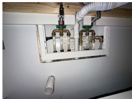
Glipper mellom samleskap og vegg.
