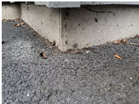
Grunnmuren er utvendig kledd med plater.
