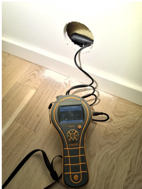
Bilde fra fuktmåling i veggkonstruksjon tilstøtende dusjsone.
