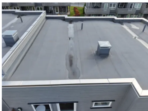
Taket er tekket med PVC-basert takmembran.
