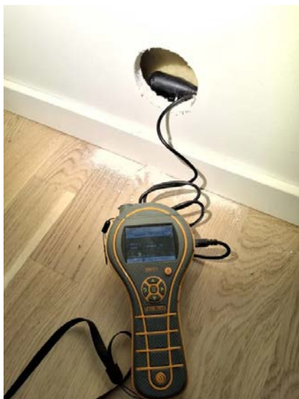
Bilde fra fuktmåling i veggkonstruksjon tilstøtende dusjsone.
