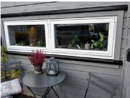
Boligen har vinduer og balkongdører med tre-lags glass.
