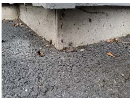
Grunnmuren er utvendig kledd med plater.
