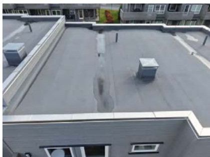
Taket er tekket med PVC-basert takmembran.
