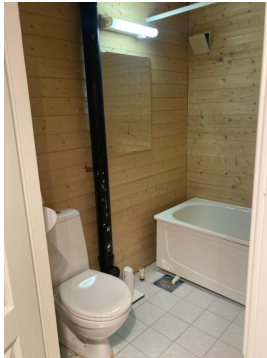
Rom med toalett i underetasje.
