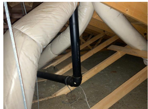
Avløpslufting på møneloft bør isoleres.
