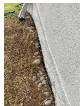
Synlig grunnmursplast uten topplst.
