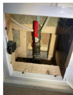
Stoppekran i vegg på soverom.
