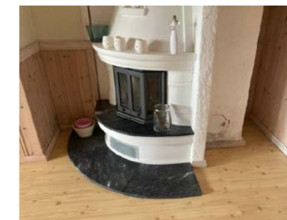
Peis med sotluke i underetasje.
