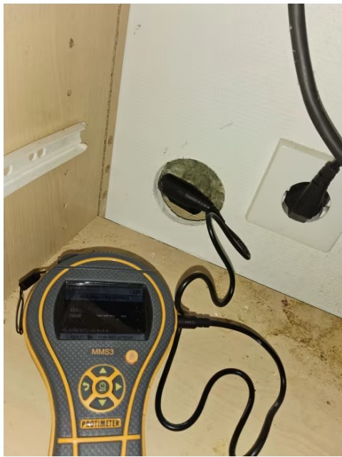
Bilde fra fuktmåling i tilstøtende veggkonstruksjon.
