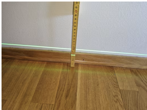
Etasjeskillet ble kontrollert med nivelleringslaser.
