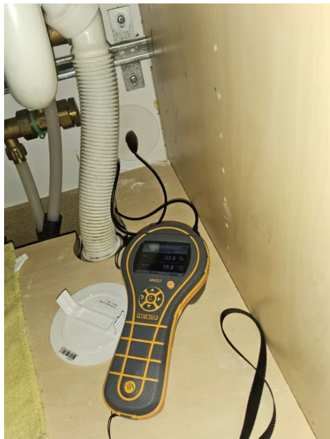
Bilde fra fuktmåling i veggkonstruksjon tilstøtende våtsone.
