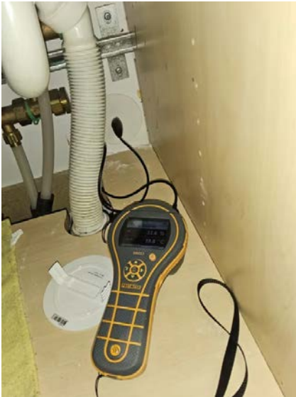
Bilde fra fuktmåling i veggkonstruksjon tilstøtende våtsone.
