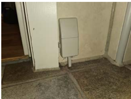
Trådløse fuktsensorer til automatisk vannstopper plassert ved dører på våtrom og ved varmtvannsbereider i bod.
