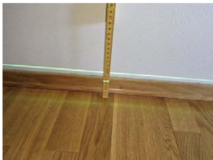
Etasjeskillet ble kontrollert med nivelleringslaser.
