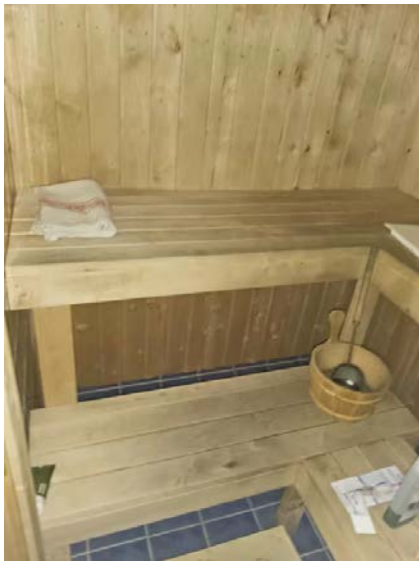
Badstue med plassbygde benker.
