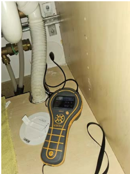
Bilde fra fuktmåling i veggkonstruksjon tilstøtende våtsone.
