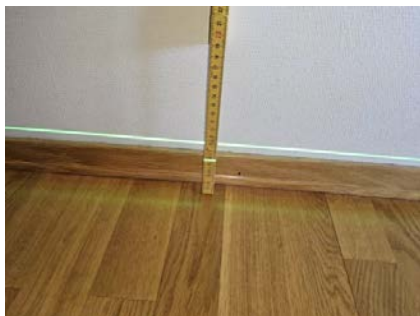
Etasjeskillet ble kontrollert med nivelleringslaser.
