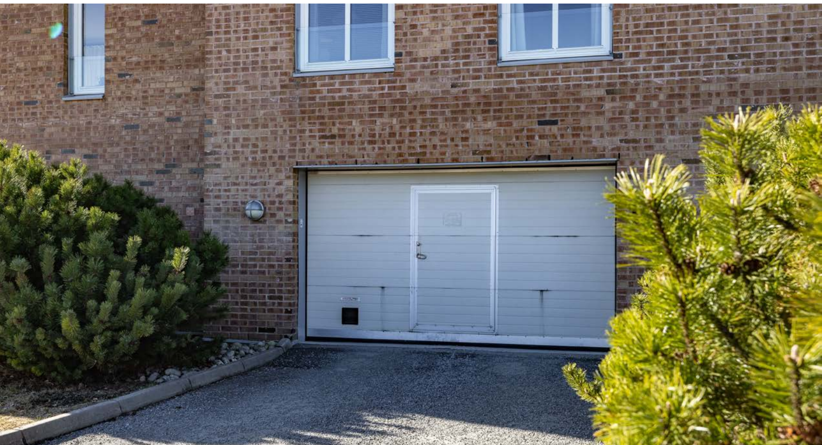
Innkjøring til garasjekjelleren. Elektrisk port.
