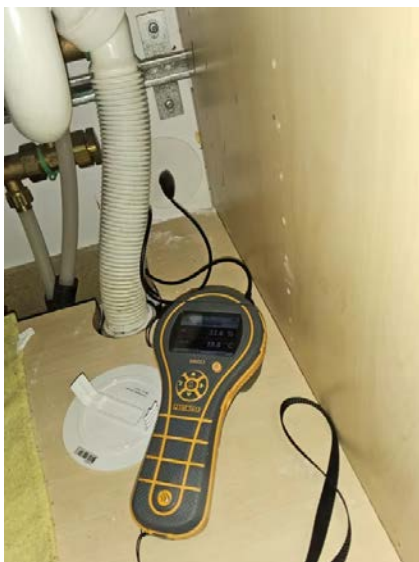
Bilde fra fuktmåling i veggkonstruksjon tilstøtende våtsone.
