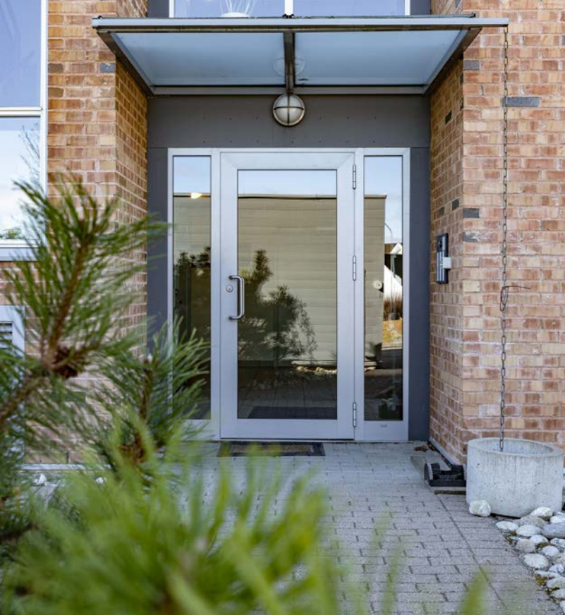
Hyggelig felles inngangsparti i byggets underetasje.
