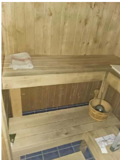
Badstue med plassbygde benker.
