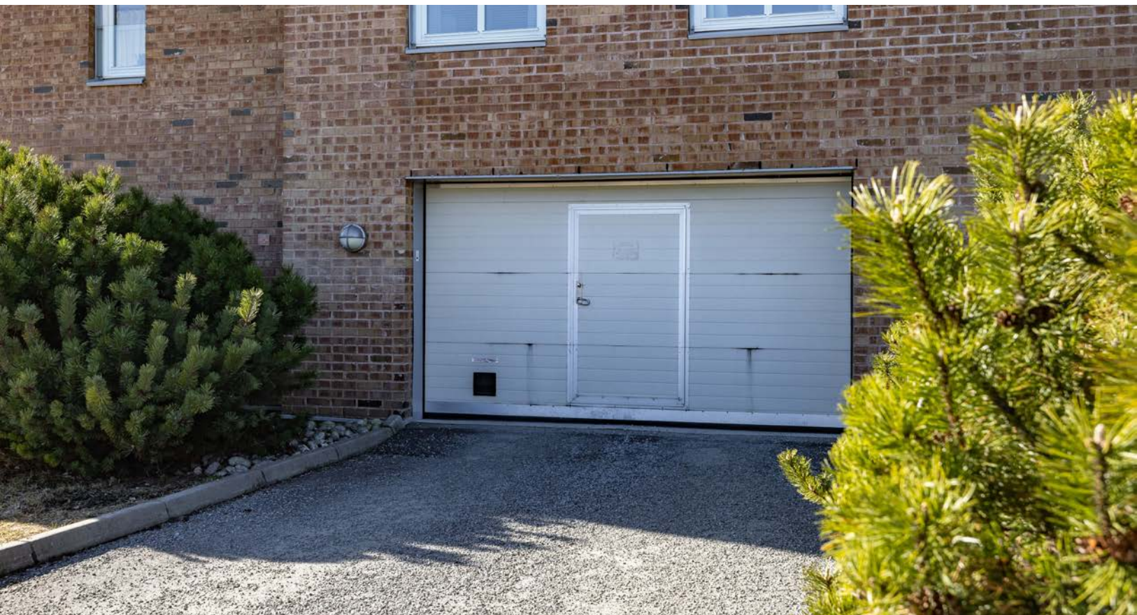
Innkjøring til garasjekjelleren. Elektrisk port.
