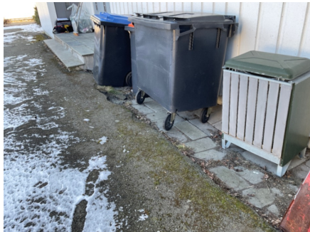
Terrenge som faller mot boligens grunnmur.
