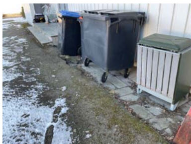
Terreng som faller mot boligens grunnmur.
