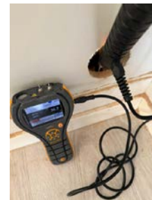
Fuktmåling i vegg under bakkenivå.
