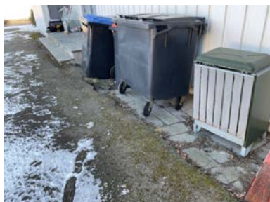
Terreng som faller mot boligens grunnmur.
