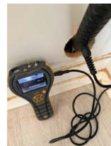
Fuktmåling i vegg under bakkenivå.
