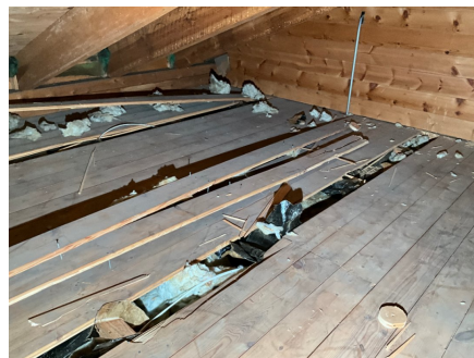
Mangler isolasjon delvis.
