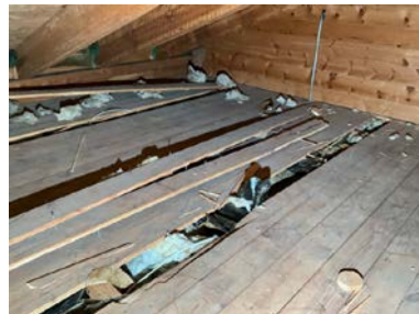
Mangler isolasjon delvis.
