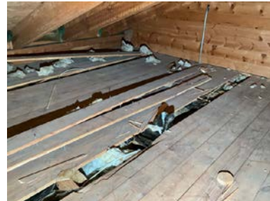
Mangler isolasjon delvis.
