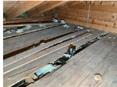
Mangler isolasjon delvis.
