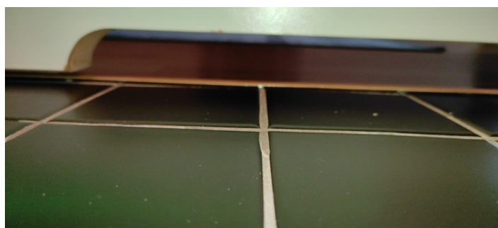
Kontroll av høyde på luftespalte under døren.
