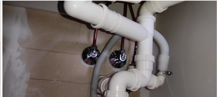
Kontroll av røropplegg.
