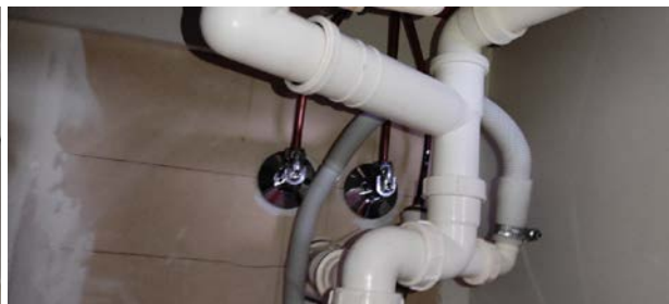
Kontroll av røropplegg.
