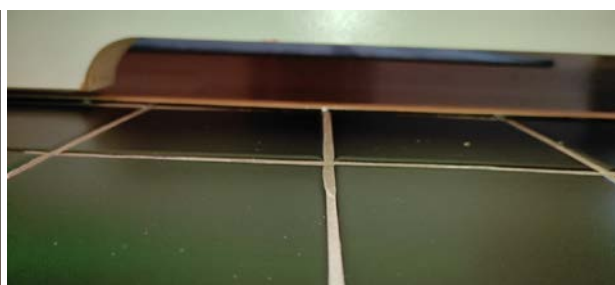
Kontroll av høyde på luftespalte under døren.
