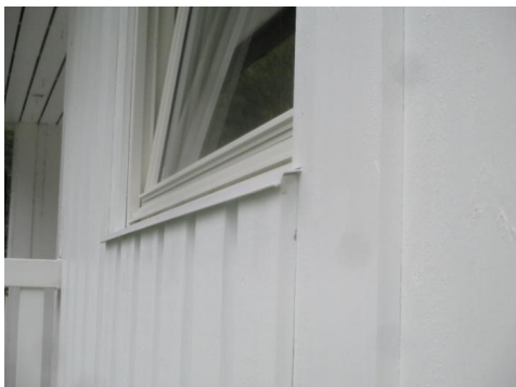
Deler av kledningen med tilhørende belistninger.
