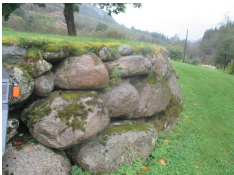
Eldre forstøtningsmur av naturstein.
