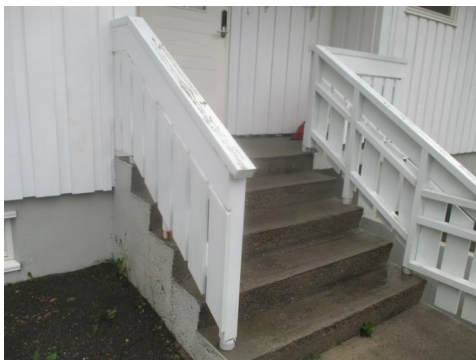
Støpt trapp med repos til hovedinngangen.
