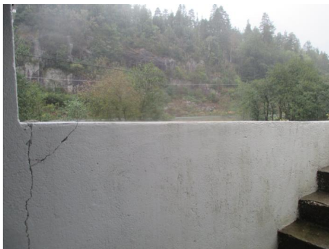
Forstøtningsmur ved kjellertrapp.
