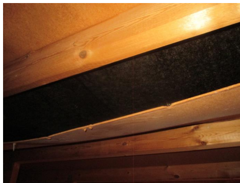
Noen av sutakplater har glidd ned i mellom takstoler.
