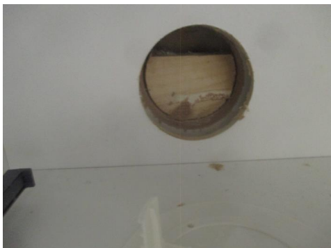
Hulltaking i utfored vegg på vaskerommet.
