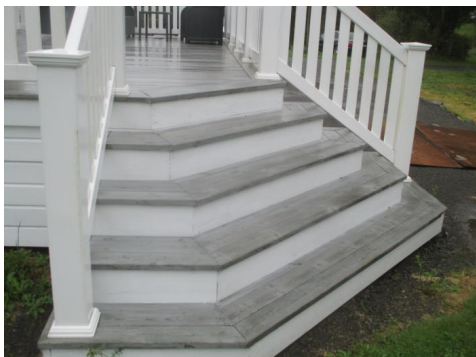
Nyere trapp til terrasse.
