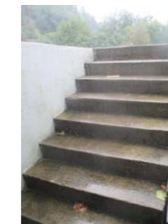
Utvendig støpt kjellertrapp.
