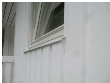
Deler av kledningen med tilhørende belistninger.
