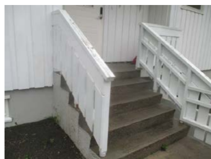
Støpt trapp med repos til hovedinngangen.
