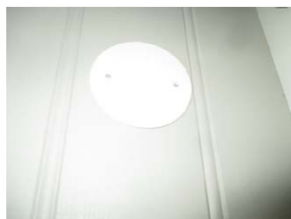
Hulltaking i fra vindfang.
