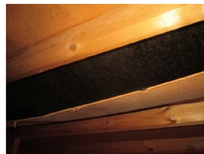
Noen av sutakplater har glidd ned i mellom takstoler.
