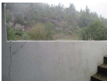
Forstøtningsmur ved kjerletrapp.
