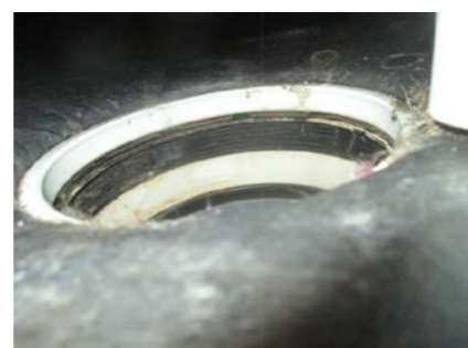
Sluk under dusjkabinett.
