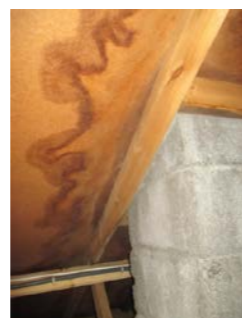
Noen av sutakplater har glidd ned i mellom takstoler.
