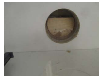
Hulltaking i utfored vegg på vaskerommet.
