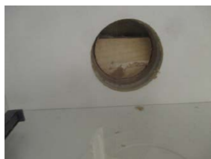
Hulltaking i utfored vegg ved skuffeseksjon.
