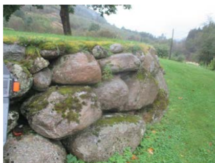
Eldre forstøtningsmur av naturstein.
