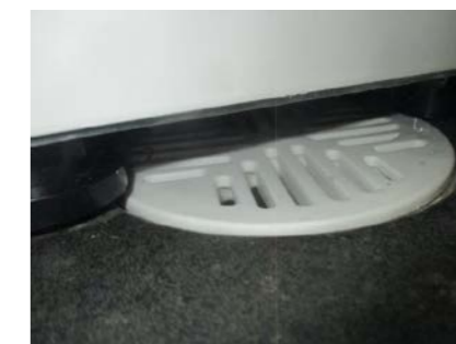
Sluk under innredningen.
