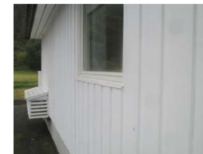
Deler av ene fasaden.
