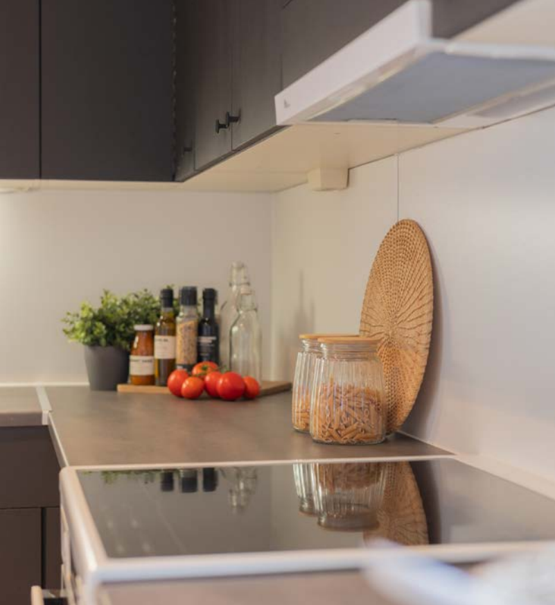
Kjøkkenventilator med avtrekk ut.
