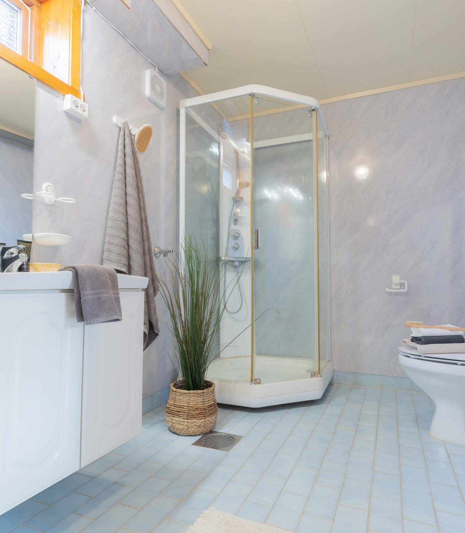
Eldre bad/vaskerom i kjelleren med flislagt gulv med gulvvarme, våtromsplater på veggene og ventilasjon igjennom el.vifte og vindusventil.
