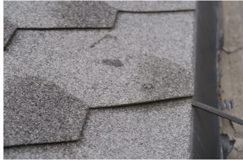
Eksempel på utstikkende spikre
