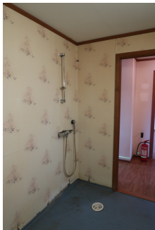
Bilde viser innerdør i dusjens våtsone
