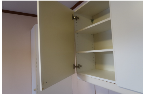
Bilde viser eksempel på skader på skaphengsel
