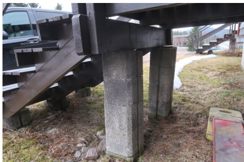
Bilde viser skjevhet i understøttelse
