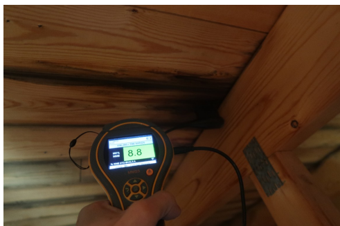
Bilde viser fuktskjolder i takkonstruksjon. Ikke skadelig fukt på befaring
