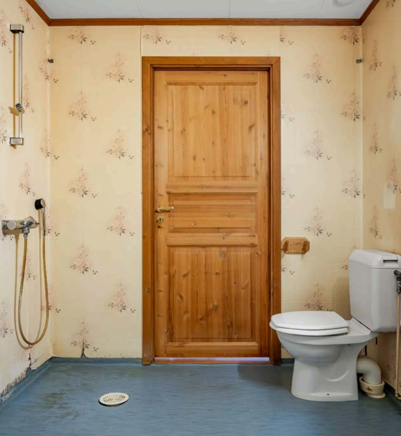
Baderommet er utstyrt med servant, toalett og vegghengt dusj uten forheng.
