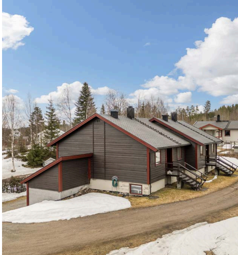
Sameiets eiendom har en opparbeidet tomt med plen, noe beplantning og intern gruset adkomstvei.
