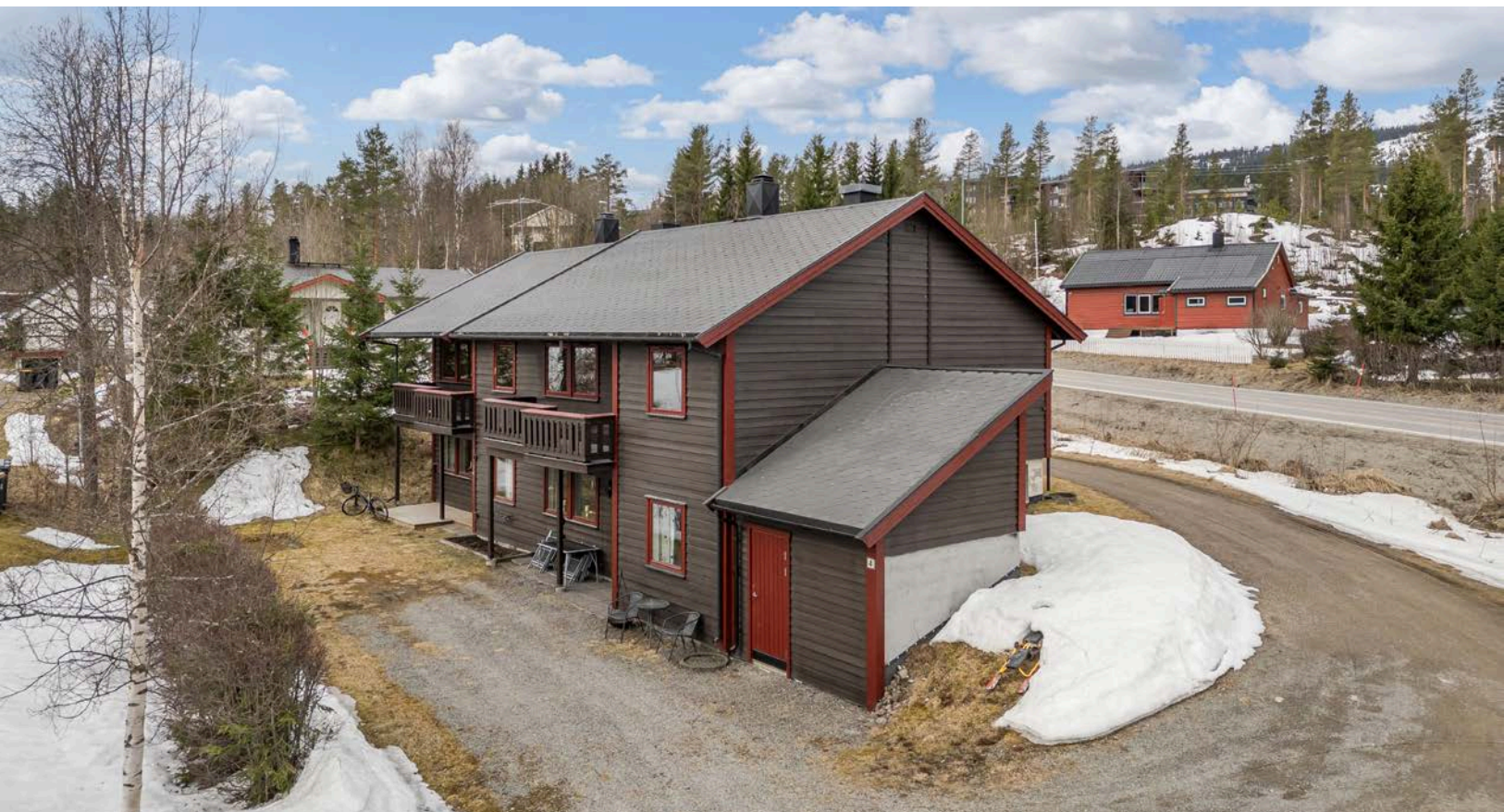
Bygningen består av to etasjer med bindingsverkskonstruksjon og liggende trekledning. Salgsobjektet ligger i 1.etasje.
