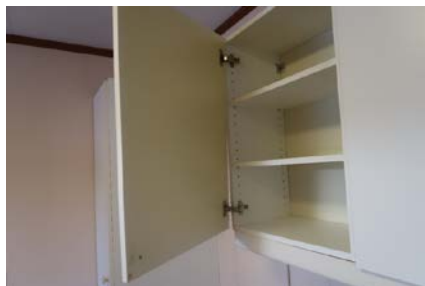
Bilde viser eksempel på skader på skaphengsel
