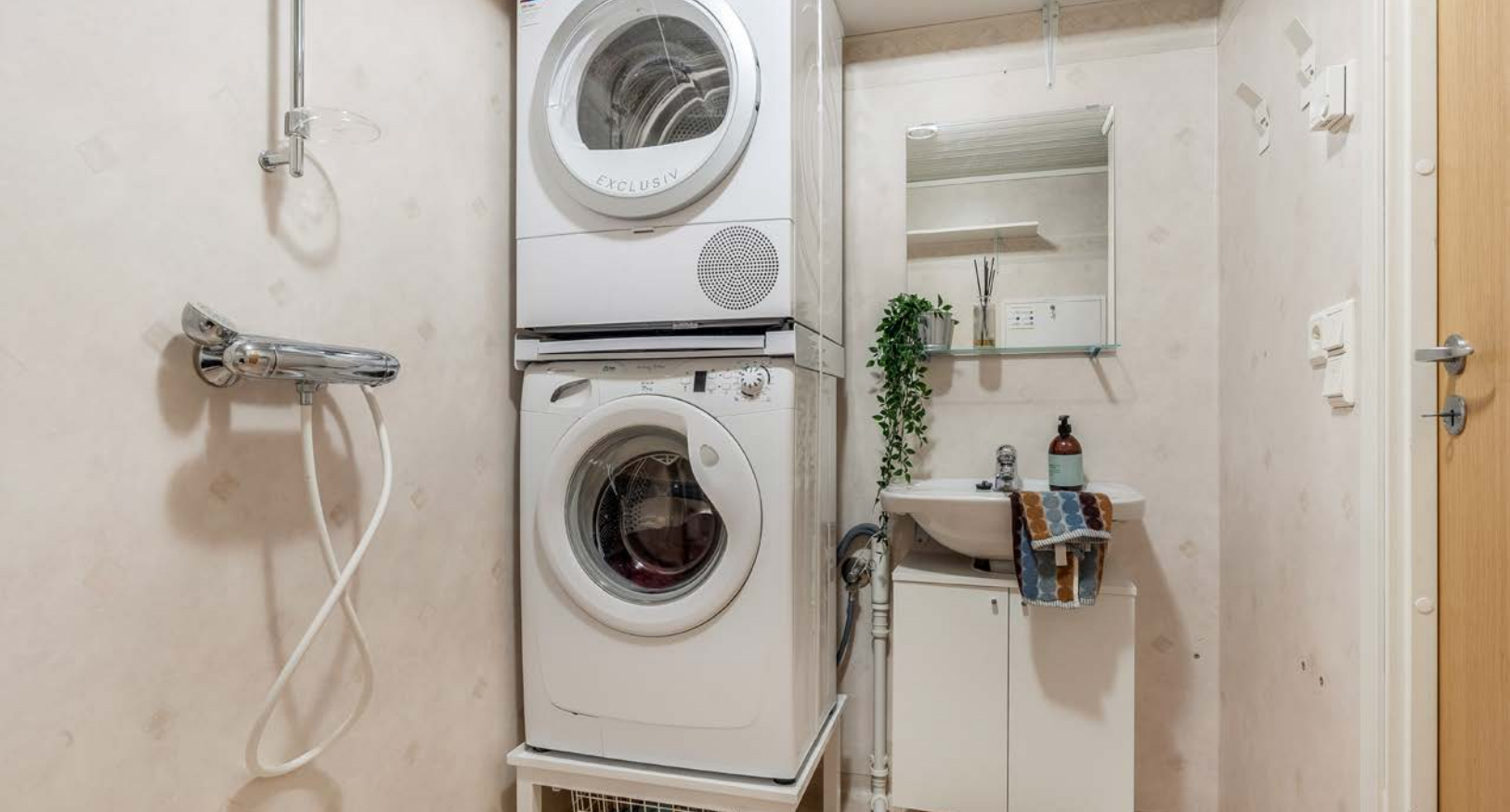
Bad/vaskerom i første etasje.
