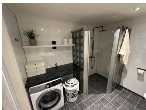
Viser dusjsonen og opplegg for vaskemaskin.
