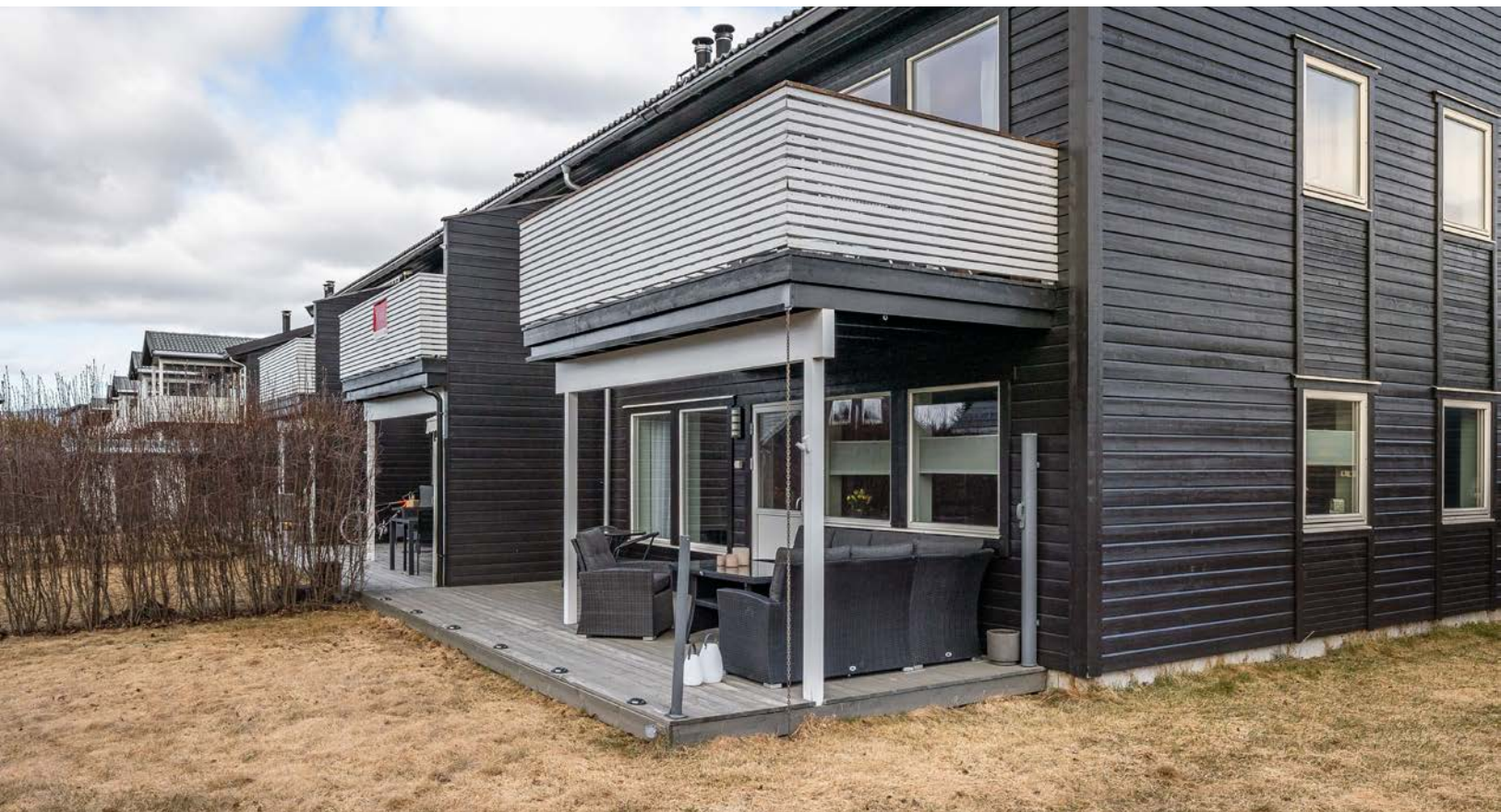
Leiligheten ligger på enden i byggets 1. etasje med en stor og solrik terrasse mot syd, samt en skjermet hjørnehage innhegnet med hekk.
