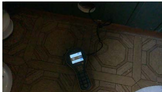
KJELLER > VASKEROM (NÅ LAGERROM)
