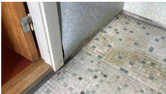
KJELLER > VASKEROM (NÅ LAGERROM)
