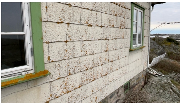
Del av vegg.
