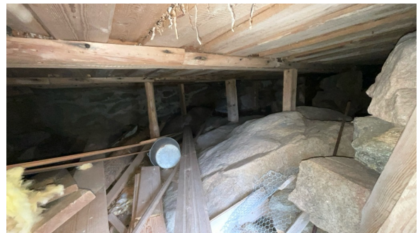
Del av krypkjeller.
