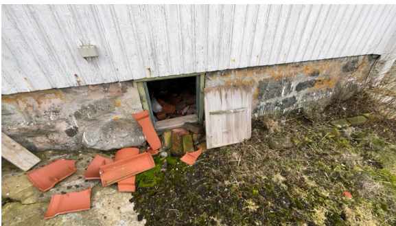
Luke inn til krypkjeller.
