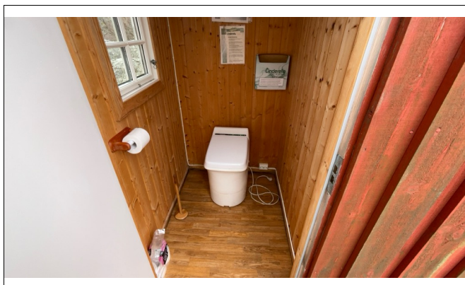
Rom i bod med montert sinderella toalett.
