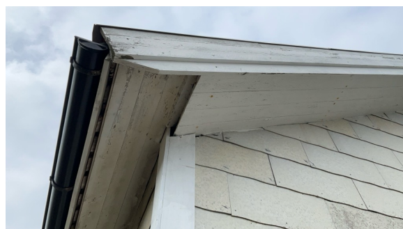
Del av gesims.
