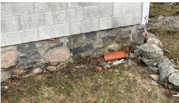
Del av grunnmur.
