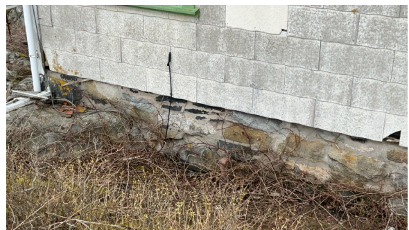
Del av grunnmur.
