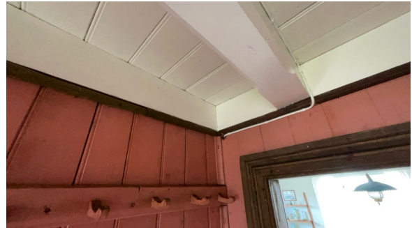
Del av vegg - tak.
