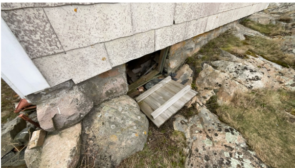
Luke inn til krypkjeller.
