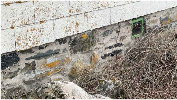
Del av grunnmur.
