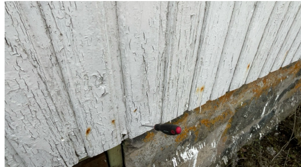
Del av vegg.
