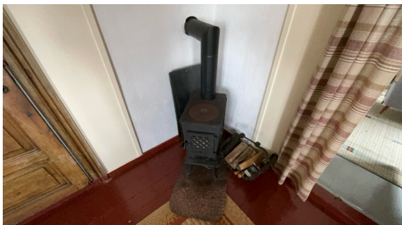
Montert ovn i stue.
