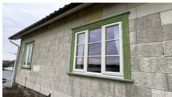
Eksempel på vindu i yttervegg.
