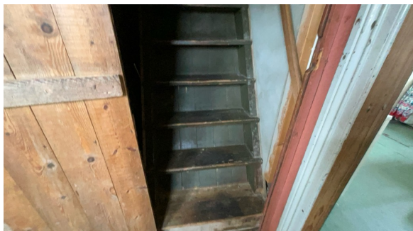
Trapp opp til 2 etasje.
