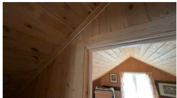
Del av vegg - tak.
