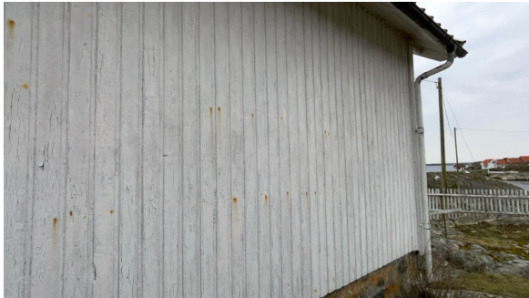
Del av vegg.
