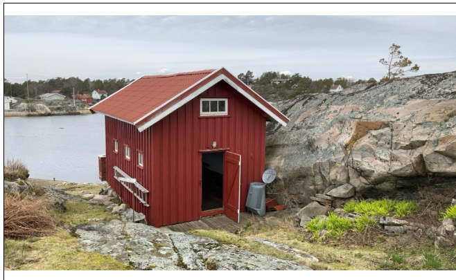
Naust oppført på eiendommen
