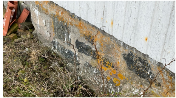
Del av grunnmur.
