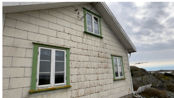
Eksempel på vindu i yttervegg.
