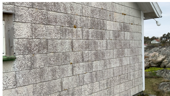
Del av vegg.
