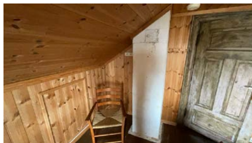
Del av pipe.
