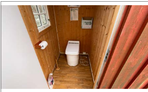
Rom i bod med montert sinderella toalett.
