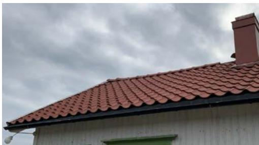
Del av taktekkning.
