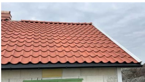
Del av taktekkning.
