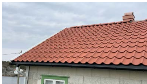
Del av taktekkning.
