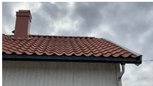
Del av taktekkning.
