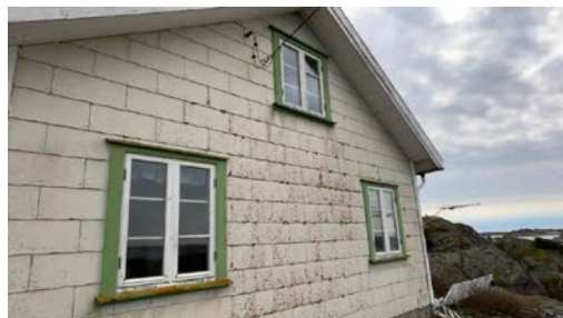
Eksempel på vindu i yttervegg.
