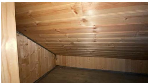
Del av takkonstruksjon, sett fra loft.
