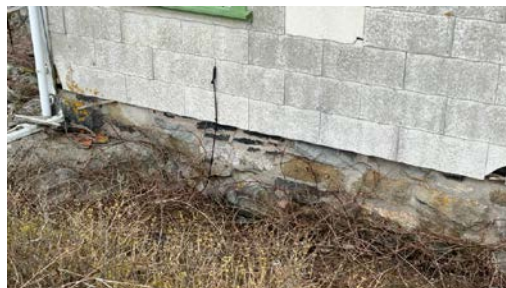
Del av grunnmur.
