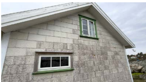
Eksempel på vindu i yttervegg.
