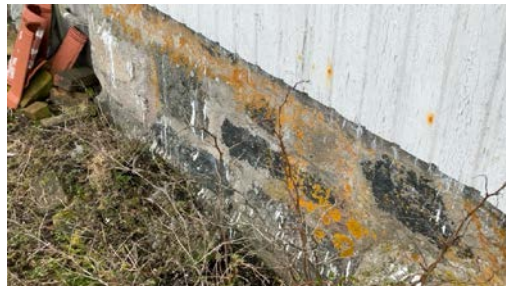
Del av grunnmur.
