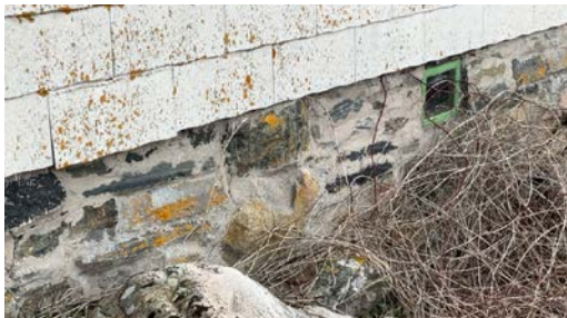
Del av grunnmur.
