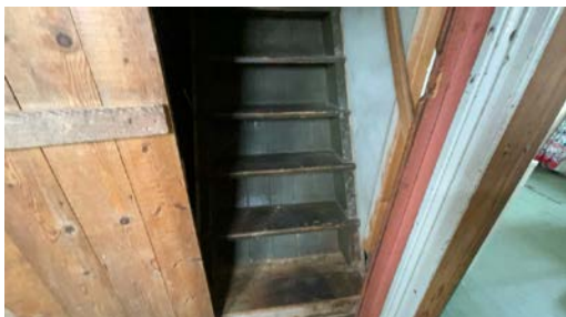
Trapp opp til 2 etasje.
