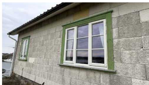
Eksempel på vindu i yttervegg.
