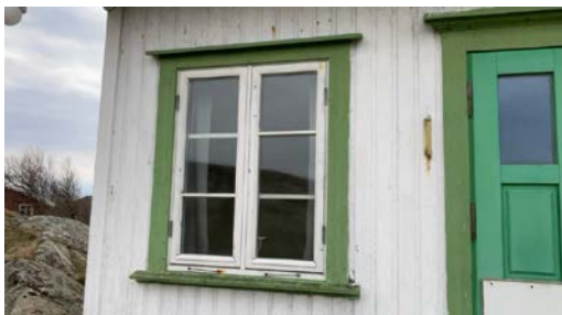
Eksempel på vindu i yttervegg.
