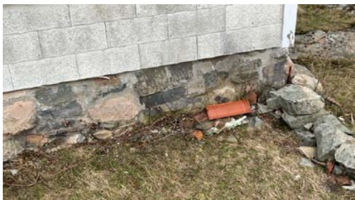
Del av grunnmur.
