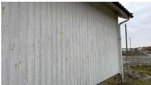
Del av vegg.
