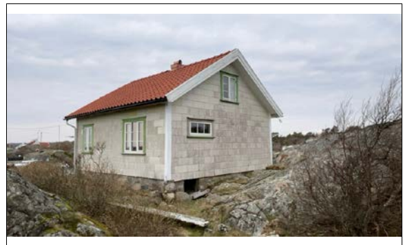
Hus oppfør på eiendommen.
