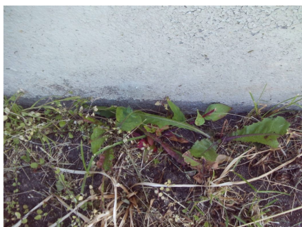
Eldre fuktsikring av grunnmur
