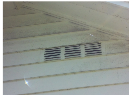
Lufting av mindre loft over tilbygget del.
