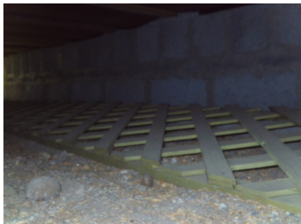
Deler av krypkjeller.
