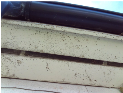
Luftespalter i gesimser.
