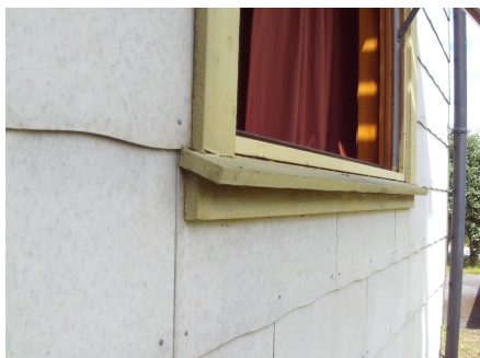
Deler av fasadeplater med tilhørende belistninger.
