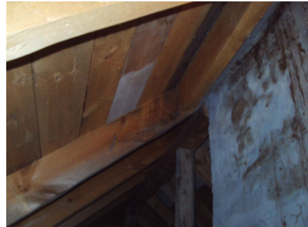
Deler av takkonstruksjonen.
