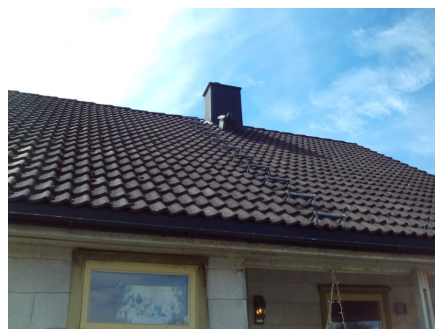
Deler av taktekkingen.
