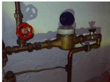
Innvendig stoppekran med vannmåler.
