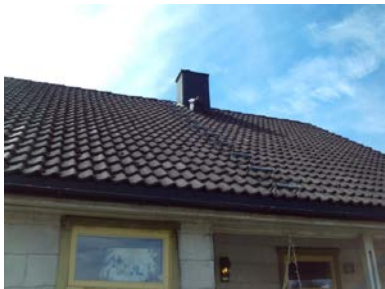
Deler av taktekkingen.
