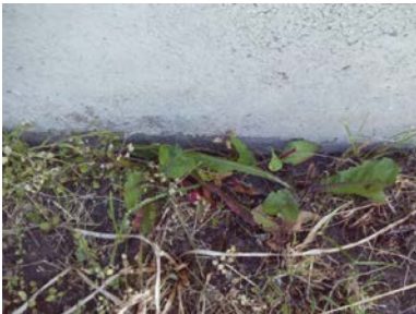
Eldre fuktsikring av grunnmur
