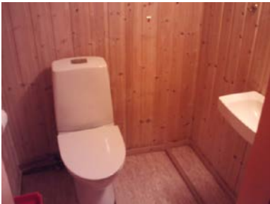
Deler av toalettrommet.
