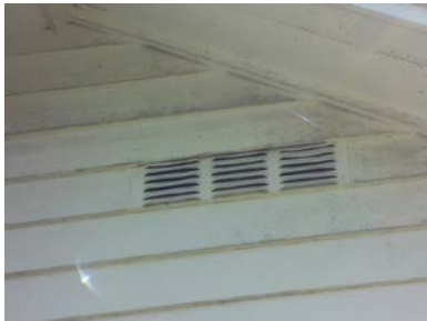
Lufting av mindre loft over tilbygget del.
