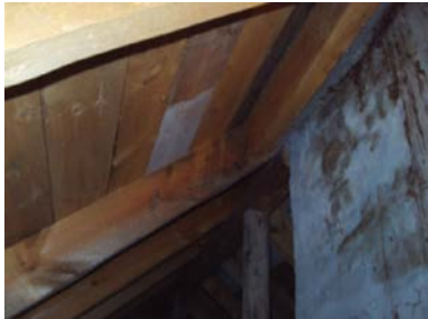
Deler av takkonstruksjonen.
