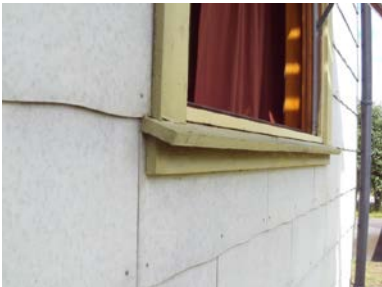
Deler av fasadeplater med tilhørende belistninger.
