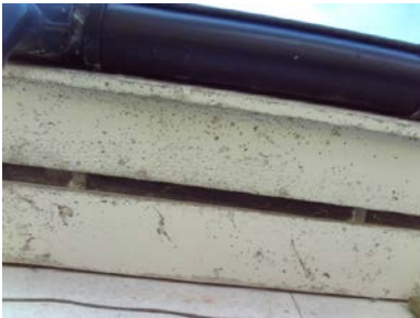
Luftespalter i gesimser.
