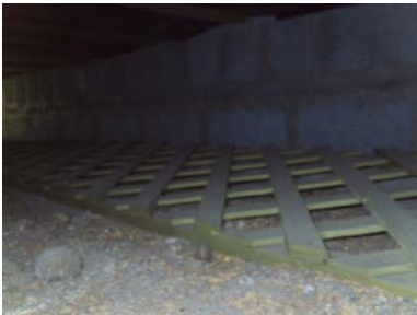
Deler av krypkjeller.
