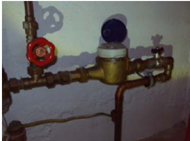
Innvendig stoppekran med vannmåler.
