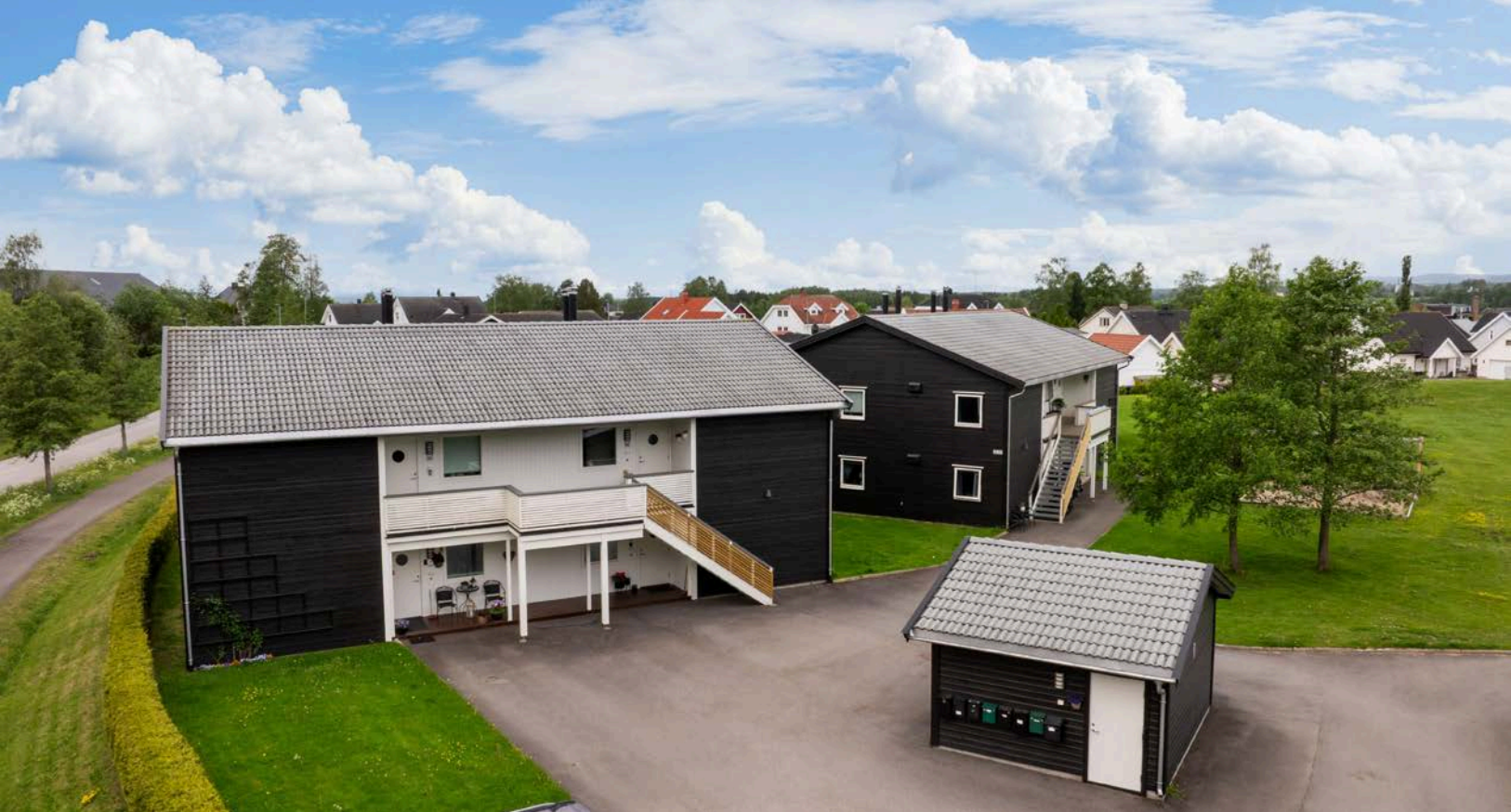
Leiligheten ligger på enden og toppen av en 4-mannsbolig som ble malt utvendig med to strøk i 2022.
