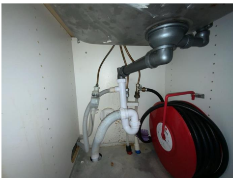
Besiktigelse av røropplegg.
