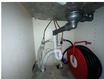
Besiktigelse av røropplegg.
