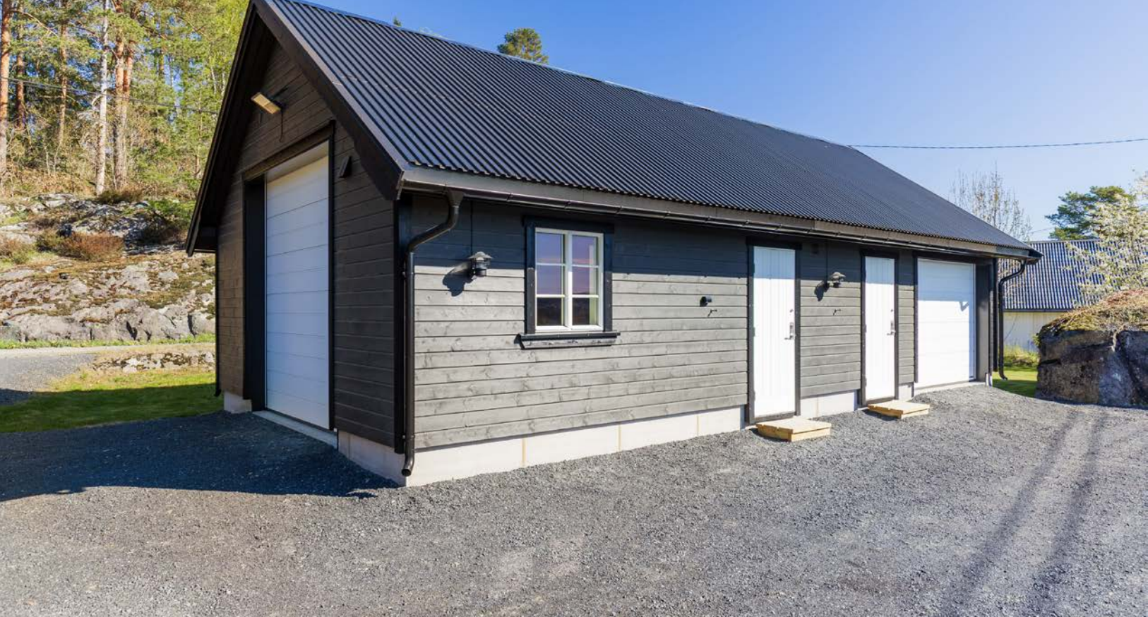
Bygget er på 64 m 2 og inneholder blant annet to garasjerom.
