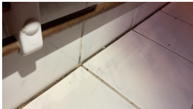
Svertesopp på mykfuger og sementbasert fuger
