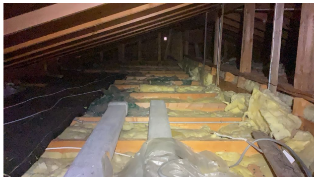
Begrenset isolering av loft
