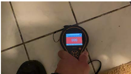
Ved overflatesøk av gulv på grunn var det fuktutslag
