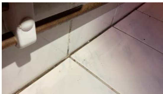
Svertesopp på mykfuger og sementbasert fuger
