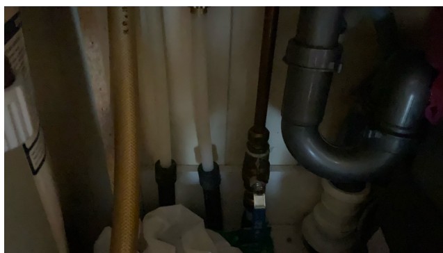
Hovedstoppekran er plassert i kjøkkenbenken.
