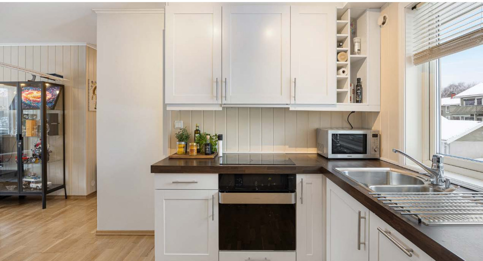
Selve innredningen består av benkeskap og overskap med folierte skrog og 1-speils hvite fronter.
