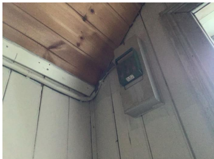
Inntakssikring er plassert i trappegang.
