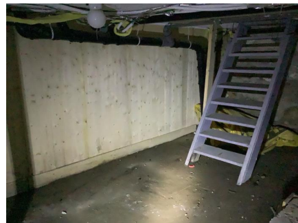
Påforet trevegg mot øst, ukjent årsak til montering av treveggen.
