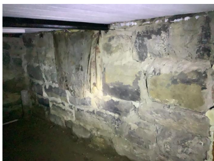
Grunnmur i stablestein.
