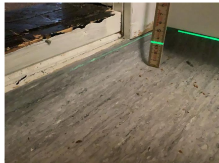
Det er 40 mm oppkant av membran ved dør.
