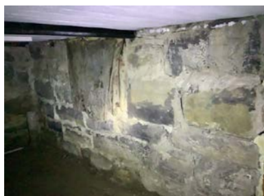
Grunnmur i stablestein.
