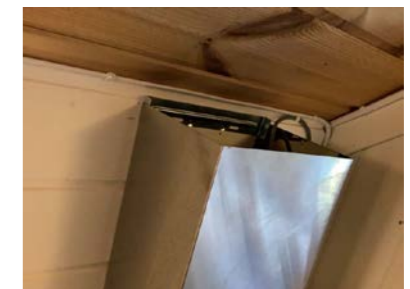
Anbefaler kannal ut på vegg fra ventilator.
