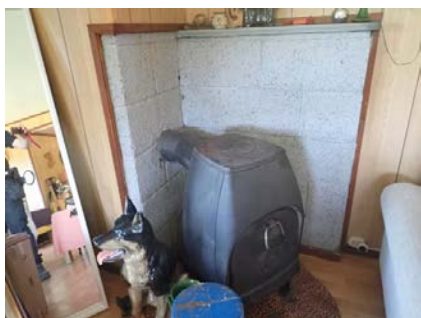
Vedovn i 1. etasje. Innkledd pipe.
