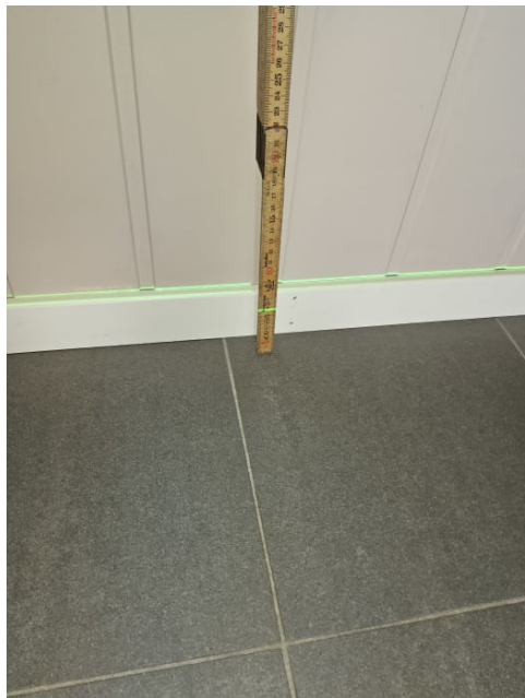
Bilde viser måling av etasjeskiller.
