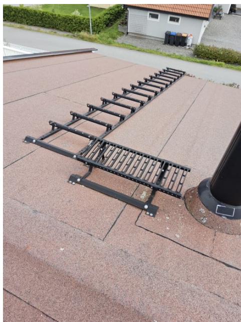
Bilde viser takstige.
