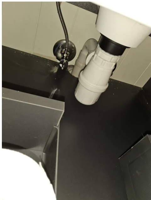
Bilde viser avløpsrør på toalettrom.
