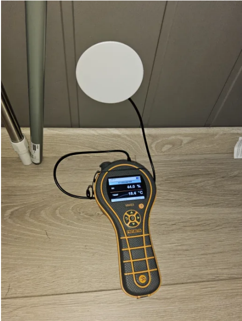
Bilde viser fuktmåling på bad.
