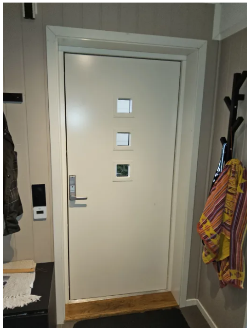
Bilde viser entrédør.
